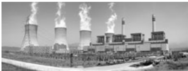
Avec 4 unités dont il assure la maintenance sur le site de la centrale de Lanxi, en Chine, Alstom franchit le cap des 1 000 réhabilitations de cylindres de turbines à vapeur dans le monde.
